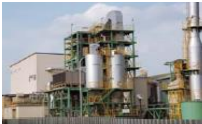
バイオマス発電所
