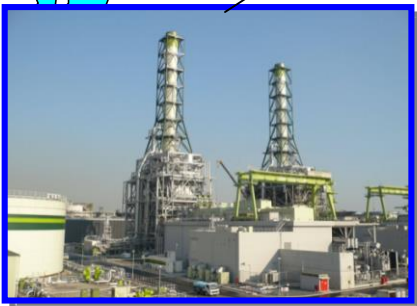
東京ガス川崎天然ガス発電所
