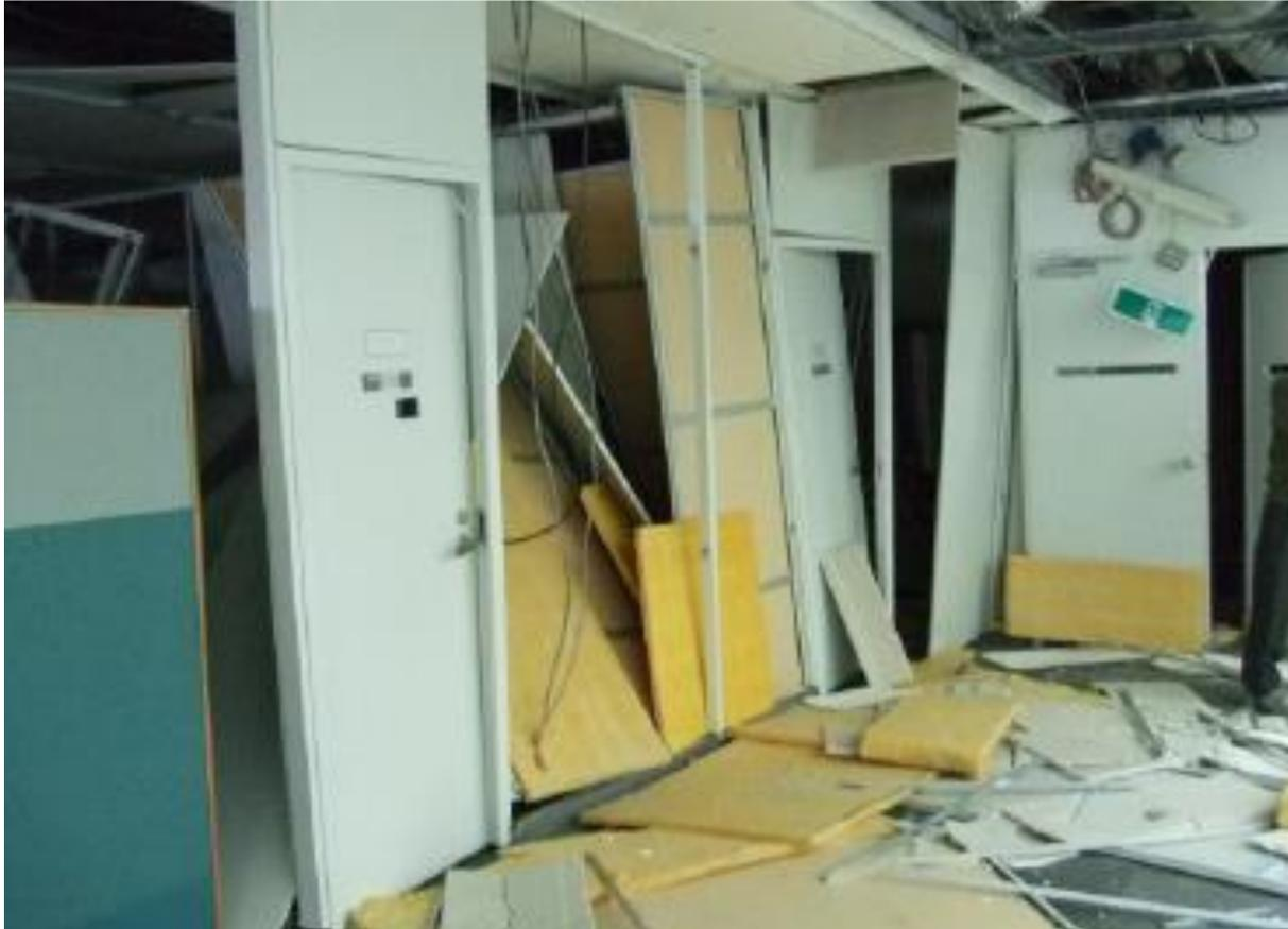
家具や壁面収納等の竣工後工事の耐震固定により、壁面自体が損傷を受けている。
