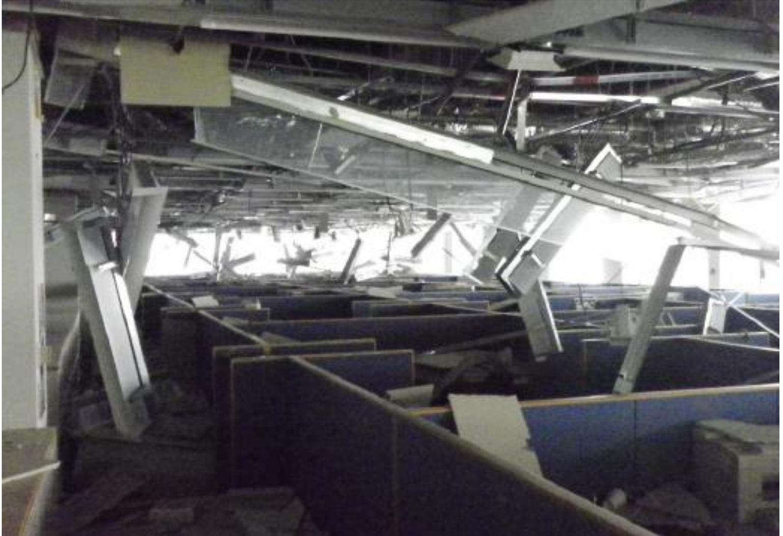
千葉幕張震度5強、鉄骨造純ラーメン構造の最上階、ラインシステム天井、余震で全面崩壊
