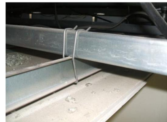
千葉幕張震度5強、鉄骨造純ラーメン構造の最上階、ラインシステム天井、余震で全面崩壊
