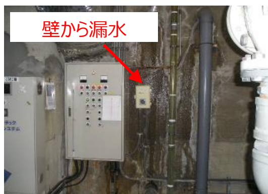
⑤漏水による機能停止（操作盤）
