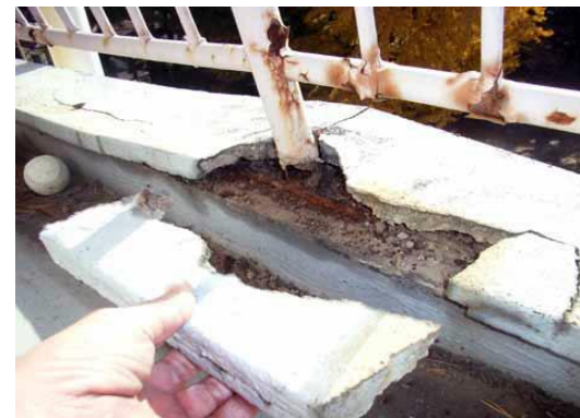
③部材の落下（バルコニー）
