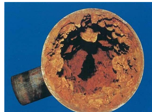
⑥配管の劣化
