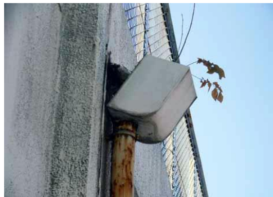
②部材の落下（外壁）
