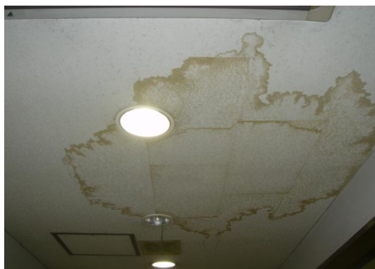
④漏水による顧客への損害
