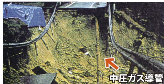
阪神大震災でも被害を受けなかった中圧ガス導管
