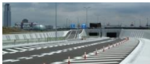
夢咲トンネル(夢洲側)
