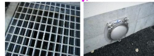
逆止弁付雨水ます 雨水排水用逆止弁
