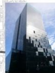
⑨ 大阪富国生命ビル建替
