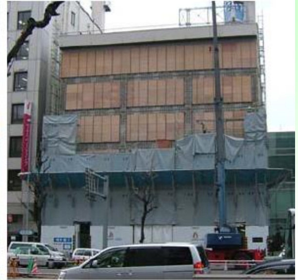
② あと施工アンカー打設
