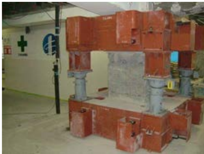
①ジャッキによる支持
