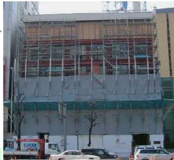
③ 鉄骨フレーム設置
