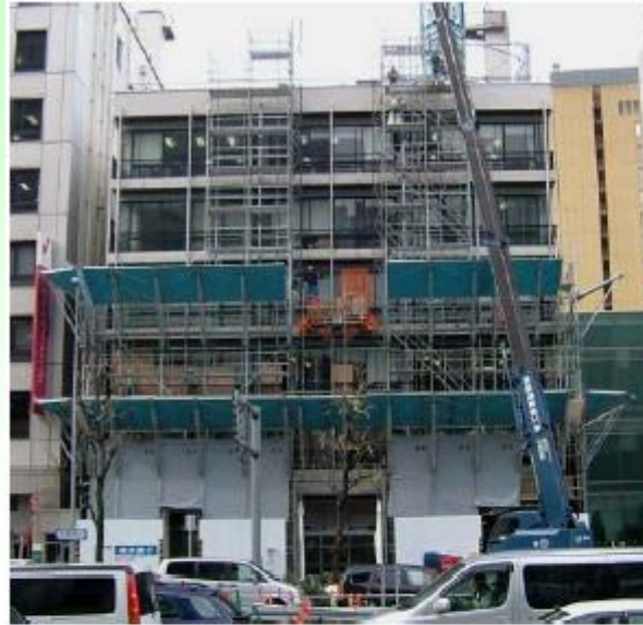
① 既存仕上げの撤去
