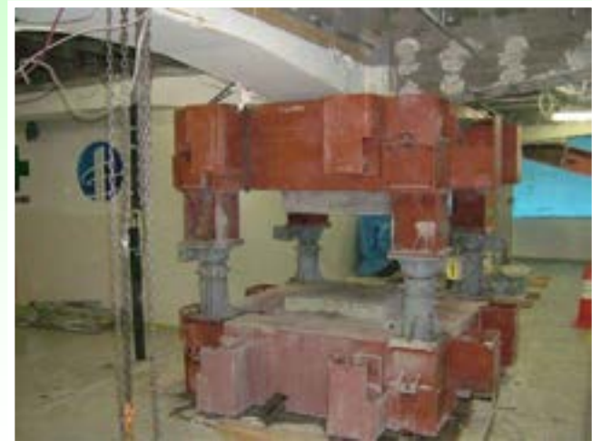
②柱の切断
