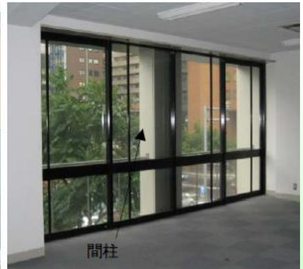
④ 補強後 内観
