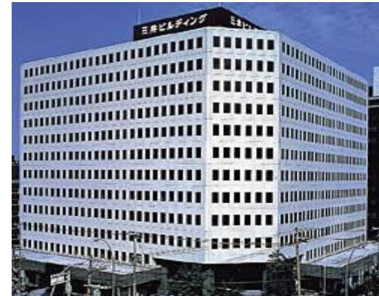
信濃橋三井ビル
