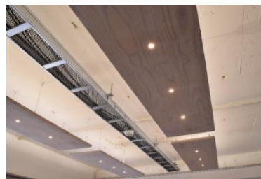
天井を外して 間接照明 を直付け
