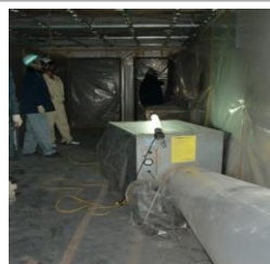
隔離養生区画内(除去作業前)
